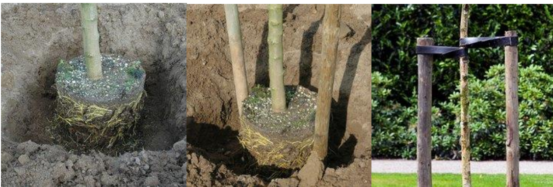
Verankeren: Het plantgat, de steunpalen plaatsen en de gekruiste elastieken.
